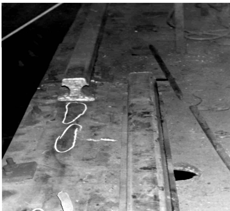
Рисунок 1 - Вид характерного контакта между рельсом и верхним поясом балки
