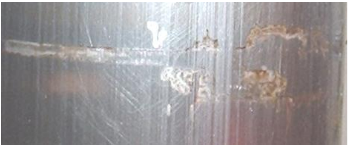
Рисунок 5 – Начальный вид изношенной поверхности со следами оспидного выкрашивания
